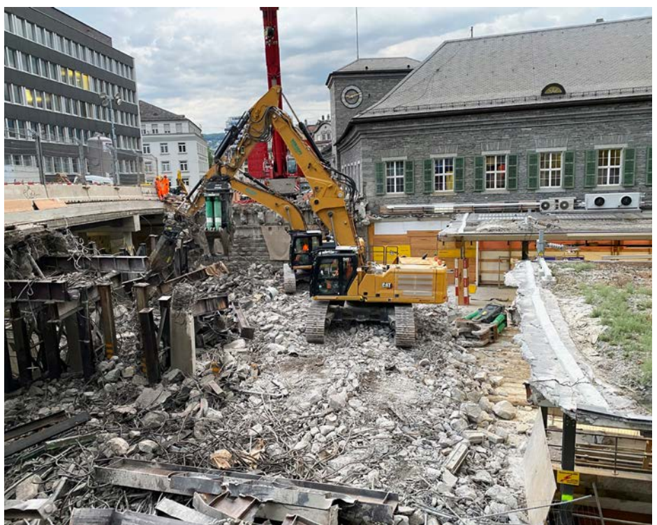
Die engen Platzverhältnisse beim Bahnhof Enge in der Stadt Zürich diktierten das Abbruchverfahren. Am Samstag war von der ersten Hälfte der Brücke nur noch Bauschutt übrig.
