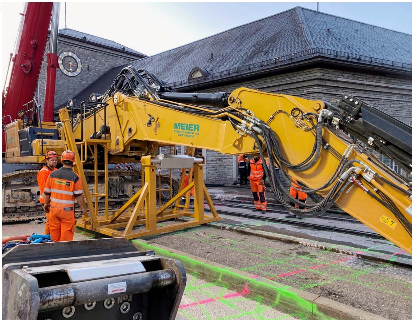
Die grünen Linien markieren Bereiche, welche die Maschinisten einhalten mussten. Darunter befanden sich die Jahre zuvor eingebauten Stahlstützen.
