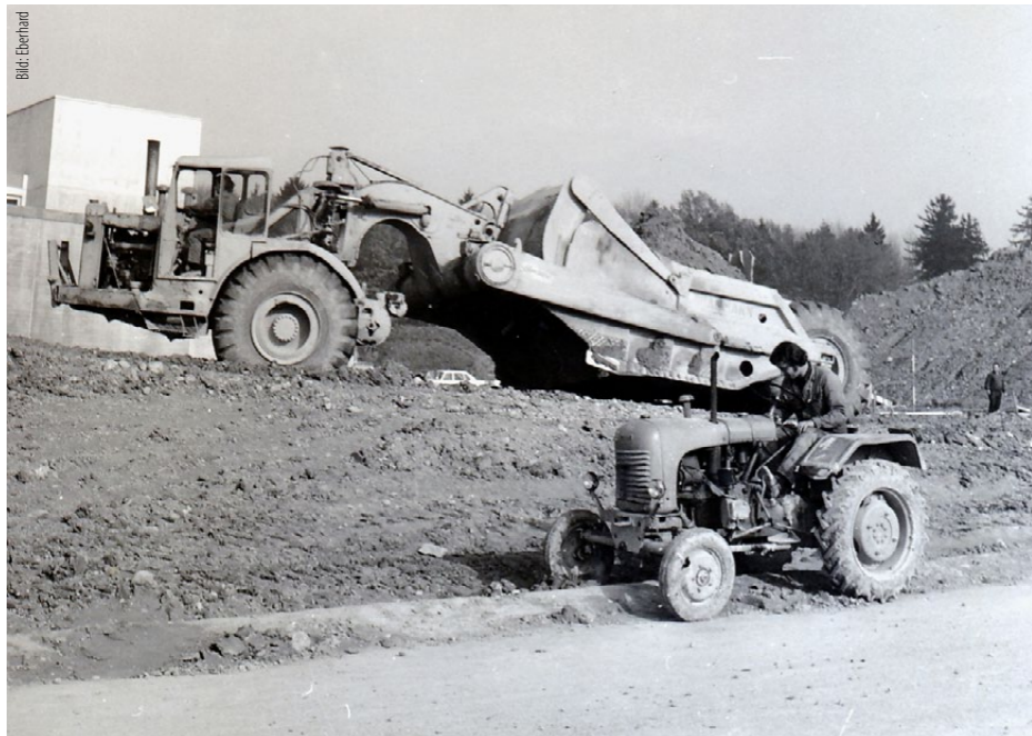
Ein Scraper im Jahr 1973 im Einsatz bei den Umgebungsarbeiten an der ETH Höggerberg.
