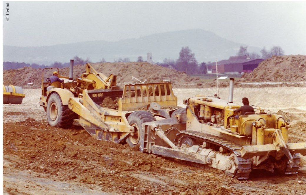
Scraper DW21 und D9E im Jahr 1976 im Einsatz
