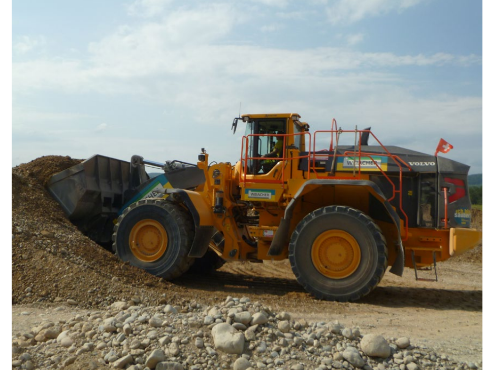
Der Radlader Volvo 350H verschiebt Material über die Grubenwand der Kieswerke Weiach. Rund sieben Kubikmeter Material fasst die Schaufel.
